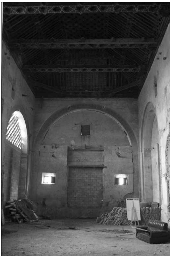
Interior del Teatro Oscense (antigua iglesia de Santo Domingo), antes del inicio de las obras de rehabilitación. Foto: Gonzalo Pulido Castillo.
