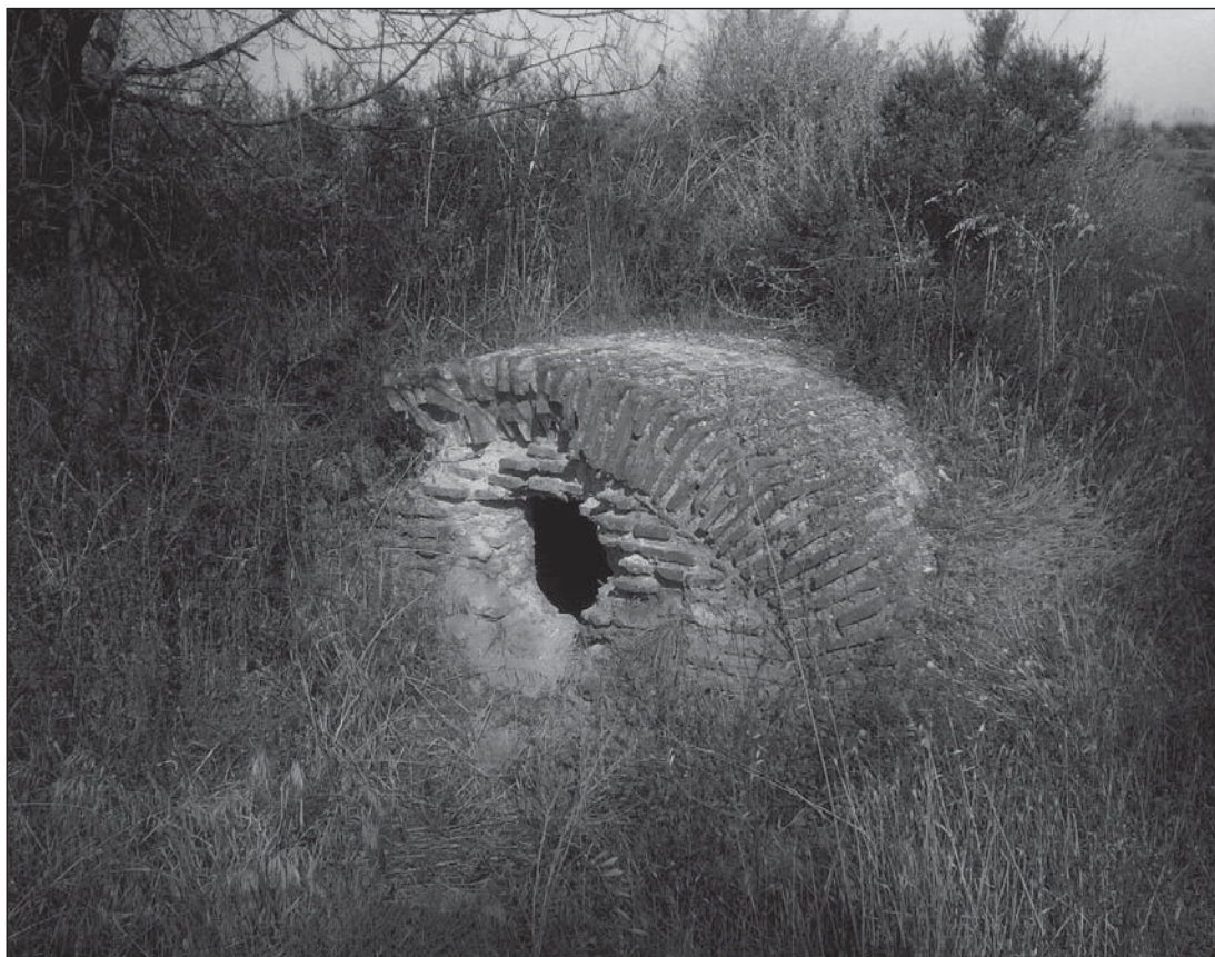
Aspecto exterior del aljibe de Face Retama.
