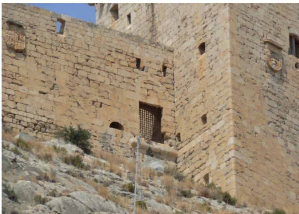
Lám. 12. La puerta del albacar en la cara sur del castillo. Junto a ella se aprecian varias troneras en la torre del homenaje para su defensa. Foto: J.A. Zapata.
