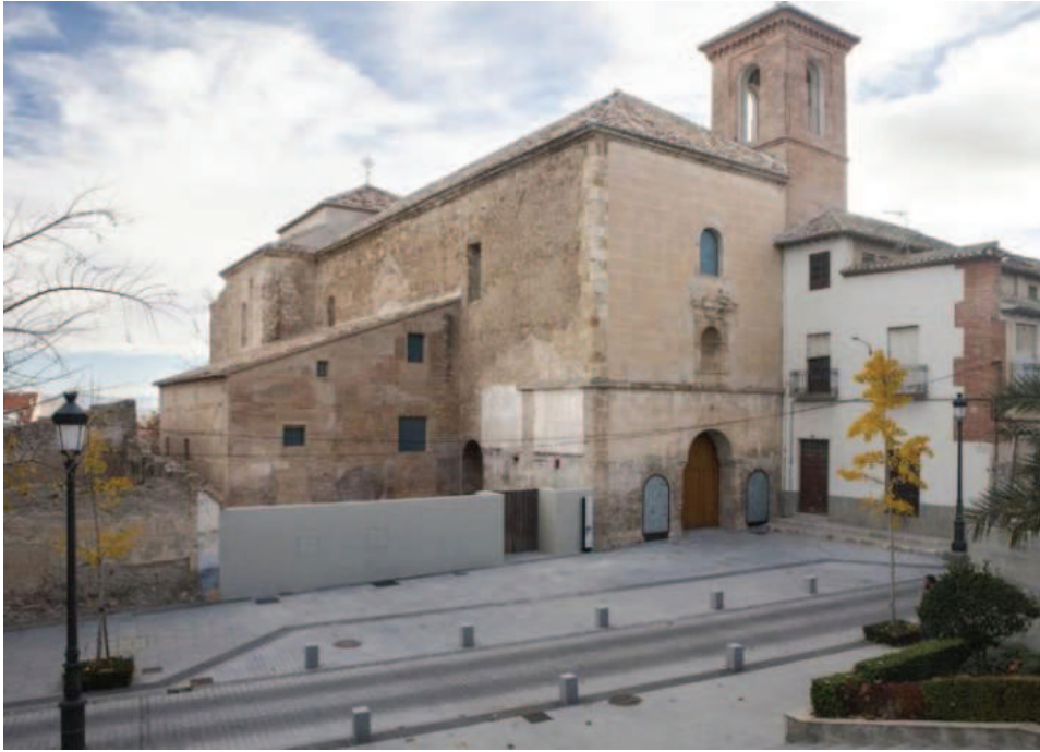
Fig. 6. Antiguo convento de frailes jerónimos de Baza. Foto: los autores.
